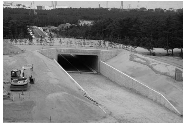
写真 3 建設中のアンダーパス（トンネル部分）。 アンダーパス上部が八間道路
