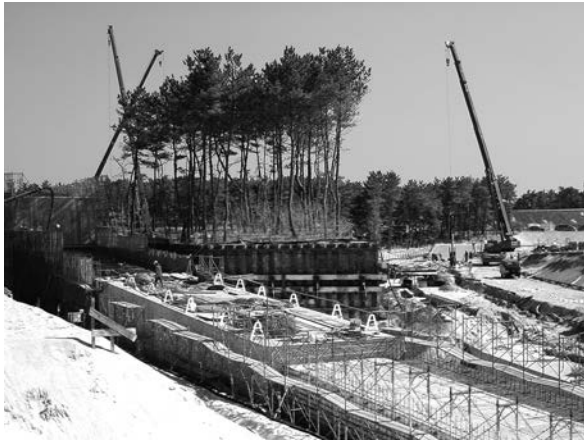
写真4 工事中も残置した松（一部）
