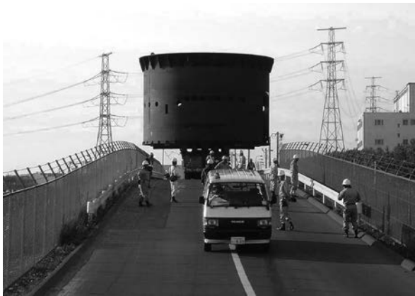
写真 14 工事用仮設道路を利用した常陸那珂港からの大型機器（アウターライナー）の搬入（04 年 10 月）
