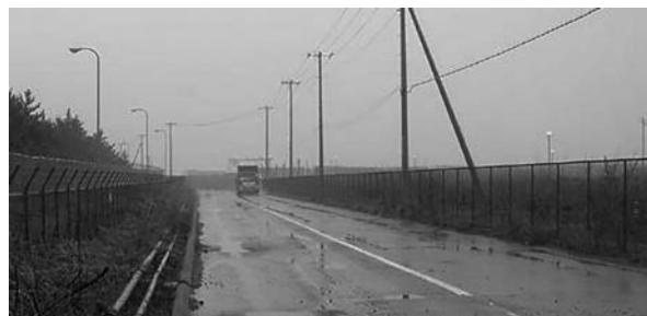
写真 13 工事用仮設道路（写真左側がサイクル機構、右側が東京電力常陸那珂火力発電所）
