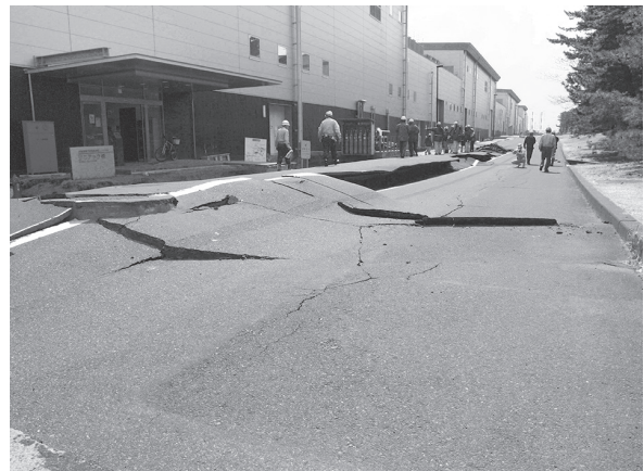
(写真 2) リニアック棟前の陥没した道路
