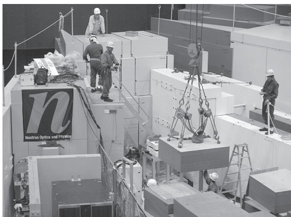
(写真7) MLF 遮蔽体積み直し作業
